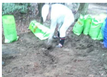
除染作業の様子
